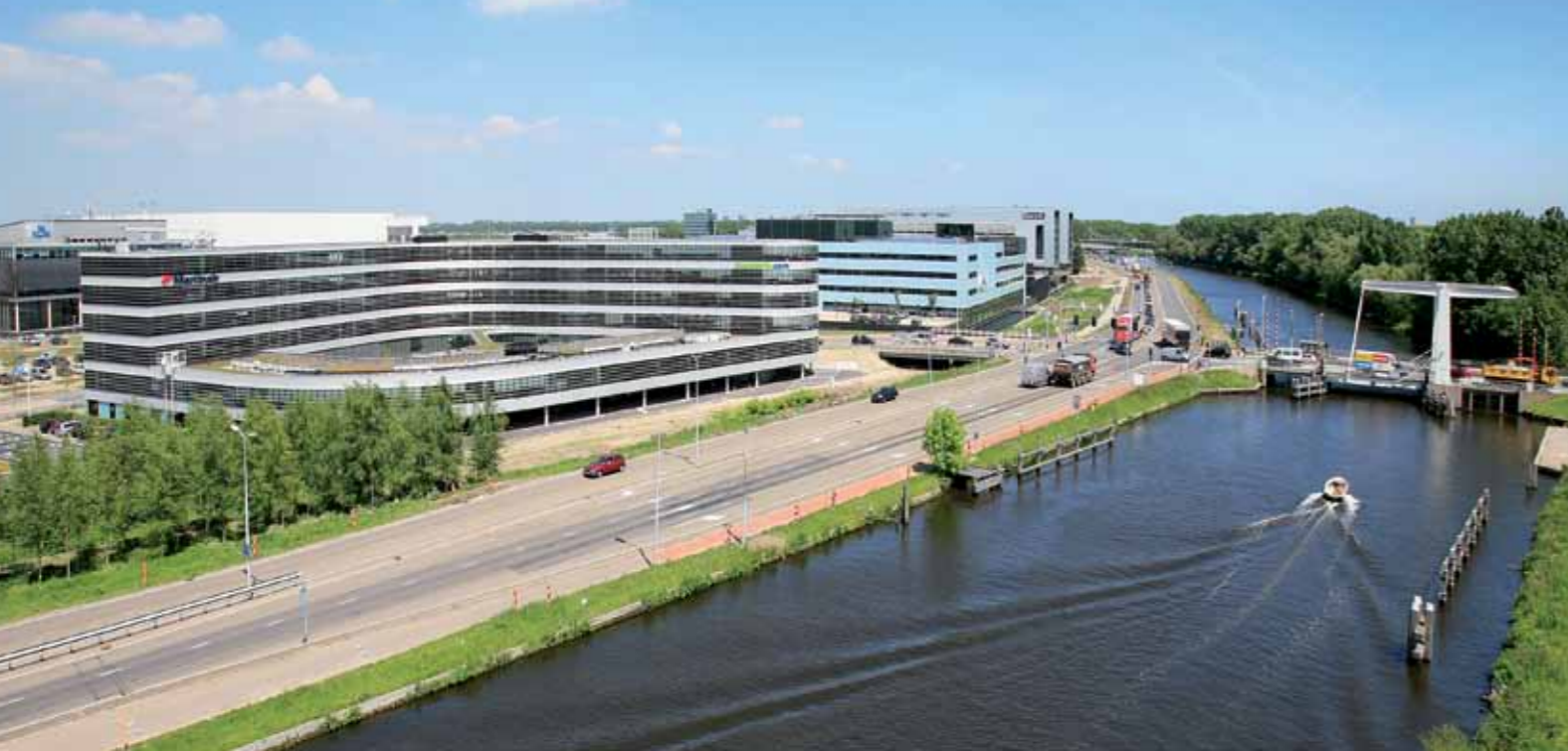
Kantoorgebouw TransPort, Amsterdam Schiphol Airport
